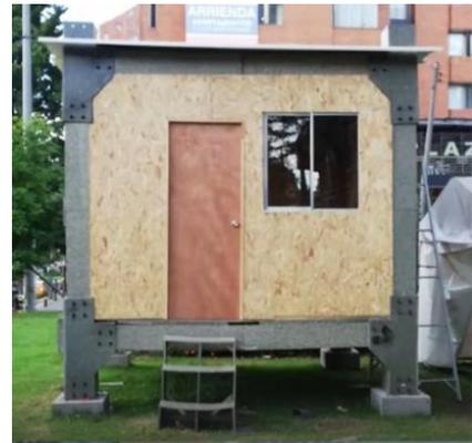
Estructura modular transportable de elementos prefabricados para la construcción de edificaciones. Comprende columnas, vigas, viguetas y piezas de acople.
